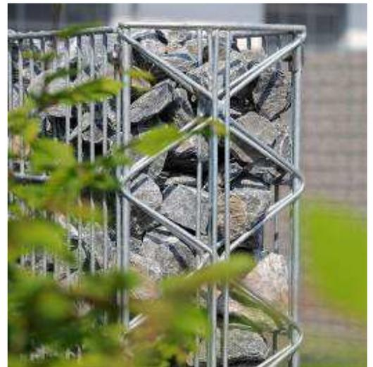
**Ruhezone: Richtig eingesetzt schlucken Klems-Gabionen Schall und Lärm – und sind zugleich gestalterisches Highlight Fotos: Eckhard Klems**
